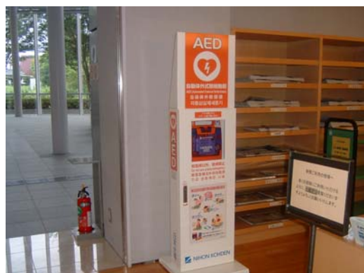
平成20年7月から館内に設置されたAED
